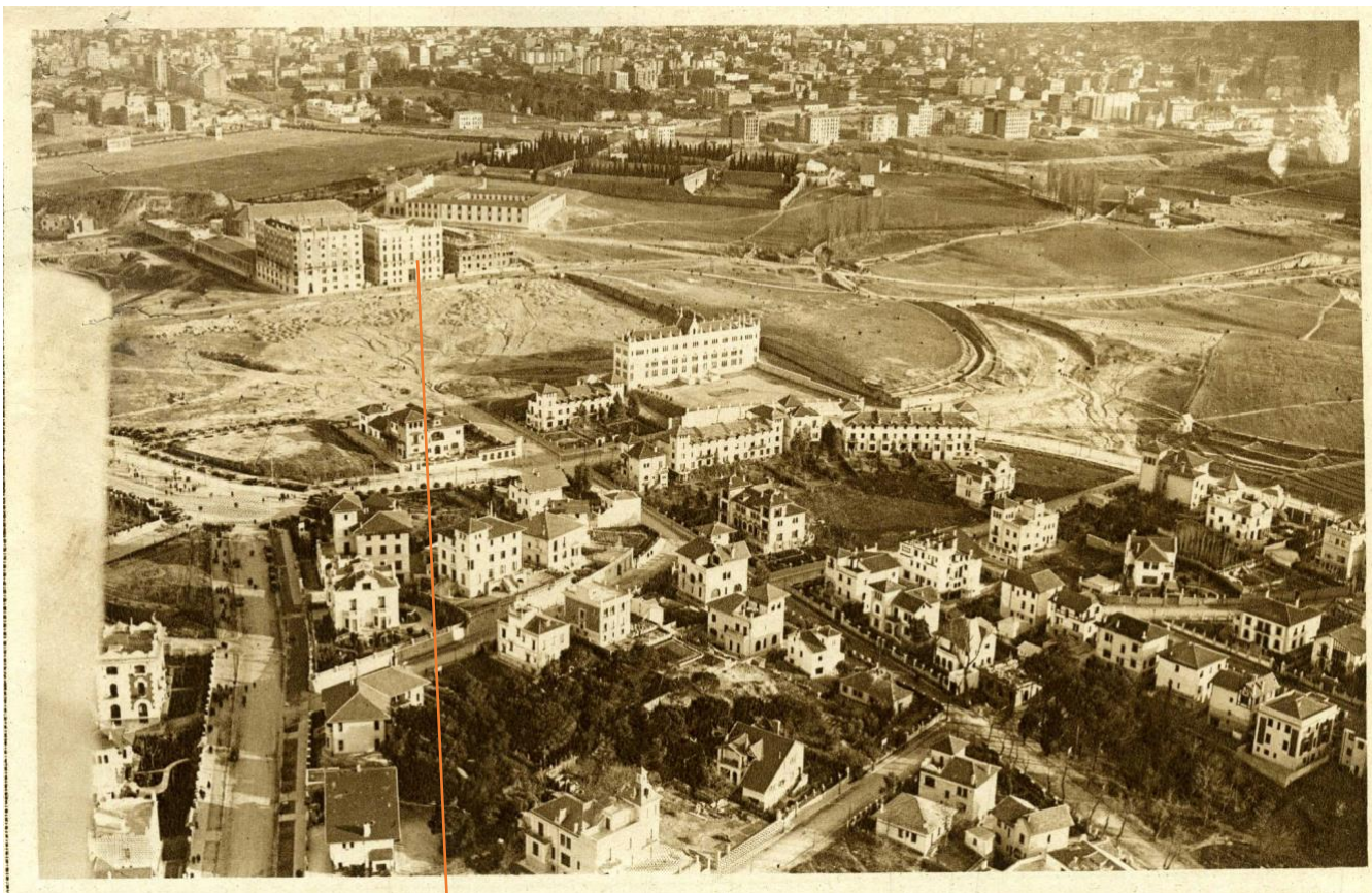
1929 : le Cuartel de la GNR en cours de construction.
